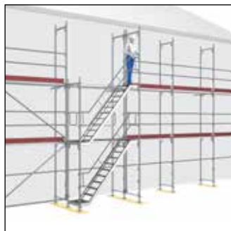
Rys. 66: Montaż poręczy schodowej
