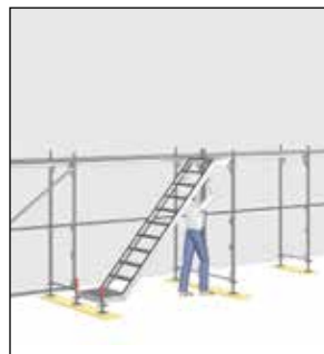
Rys. 64: Montaż schodów podestowych
